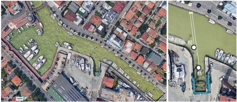
Fig. 3 – Vista dall'alto del cantiere navale GAM di Cattolica e particolare del bacino di allaggio. I cerchi in bianco indicano la posizione degli eiettori, le frecce bianche le tubazioni di scarico.
