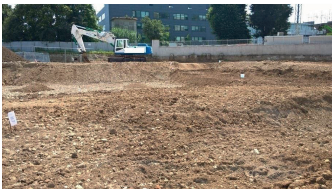
Fig. 2 – Esecuzione degli scavi di bonifica.
