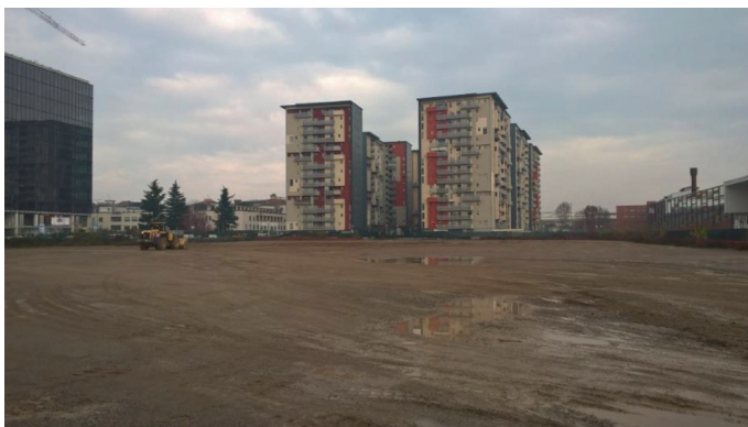
Fig. 3 – Vista del sito a seguito delle attività di ritombamento.
